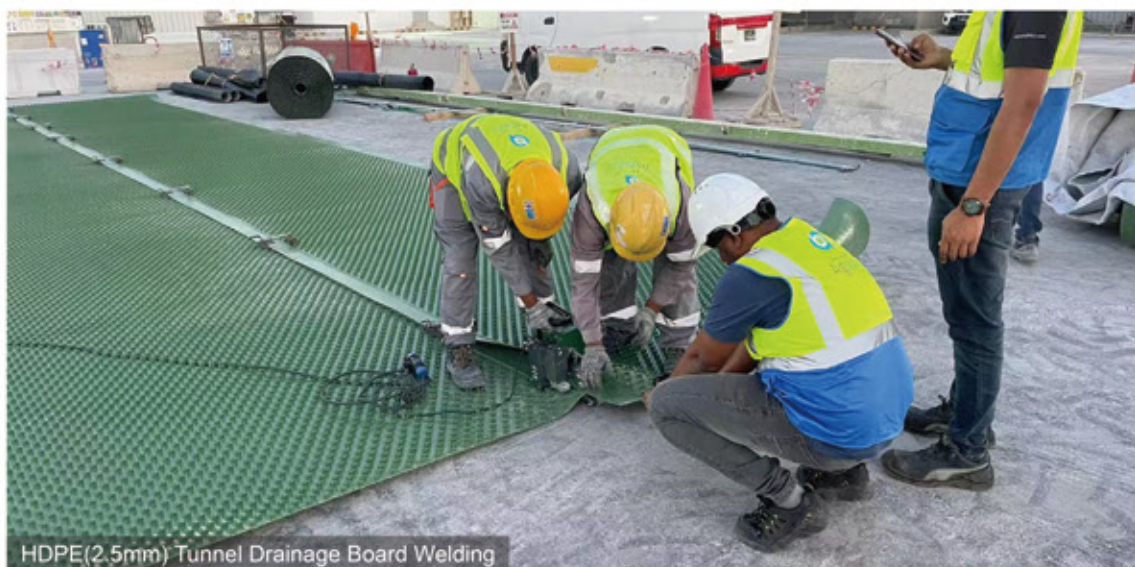
Geomembrane Material Welding
