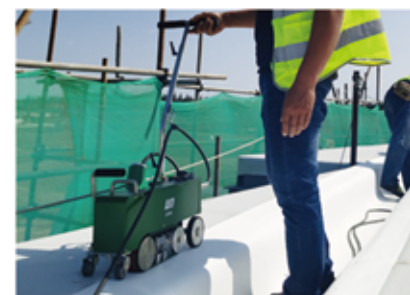
Welding Gutter Edge
